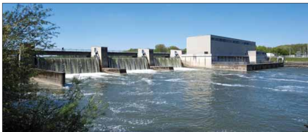
Seit 40 Jahren liefert das Kraftwerk Ingolstadt zuverlässig Strom.
